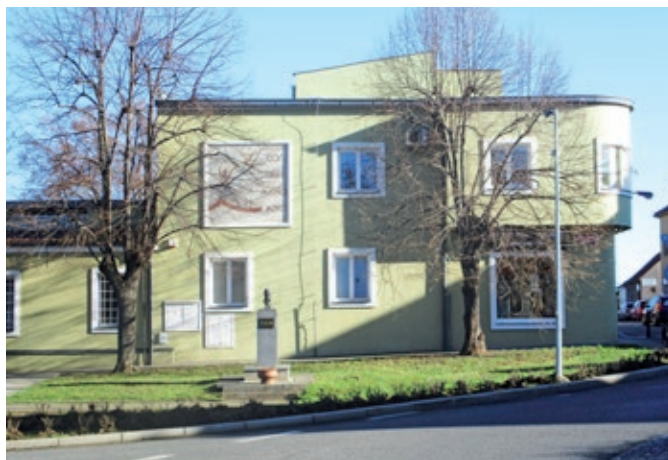
V budově č. p. 180 probíhala hlavní výroba.
